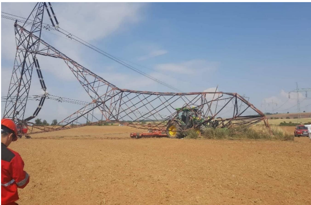
Obrázek 3 Náraz traktoru do stožárové konstrukce V430 [2]
